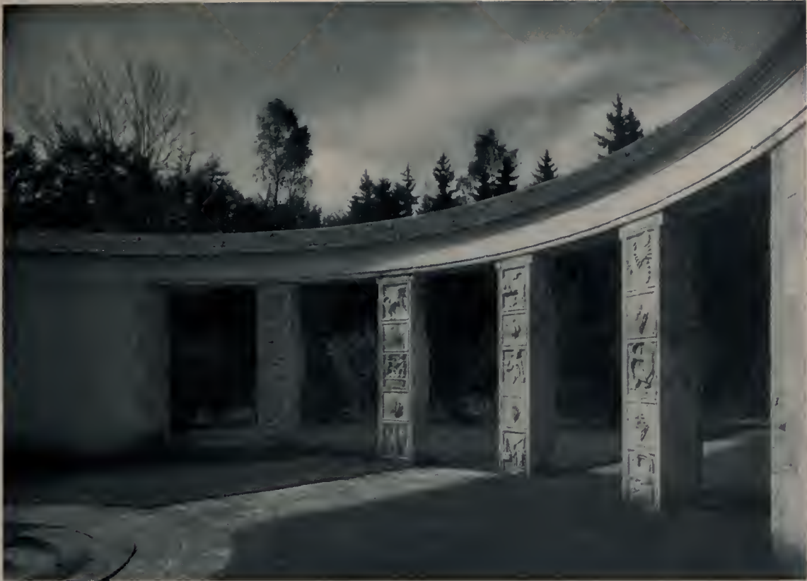
E. v. SEIDL (+) U. JUL. SEIDLER ■ GEDÄCHTNISSTÄTTE D. FAMILIE V. NEUSCHOTZ. BLICK AUF DEN EINGANG
