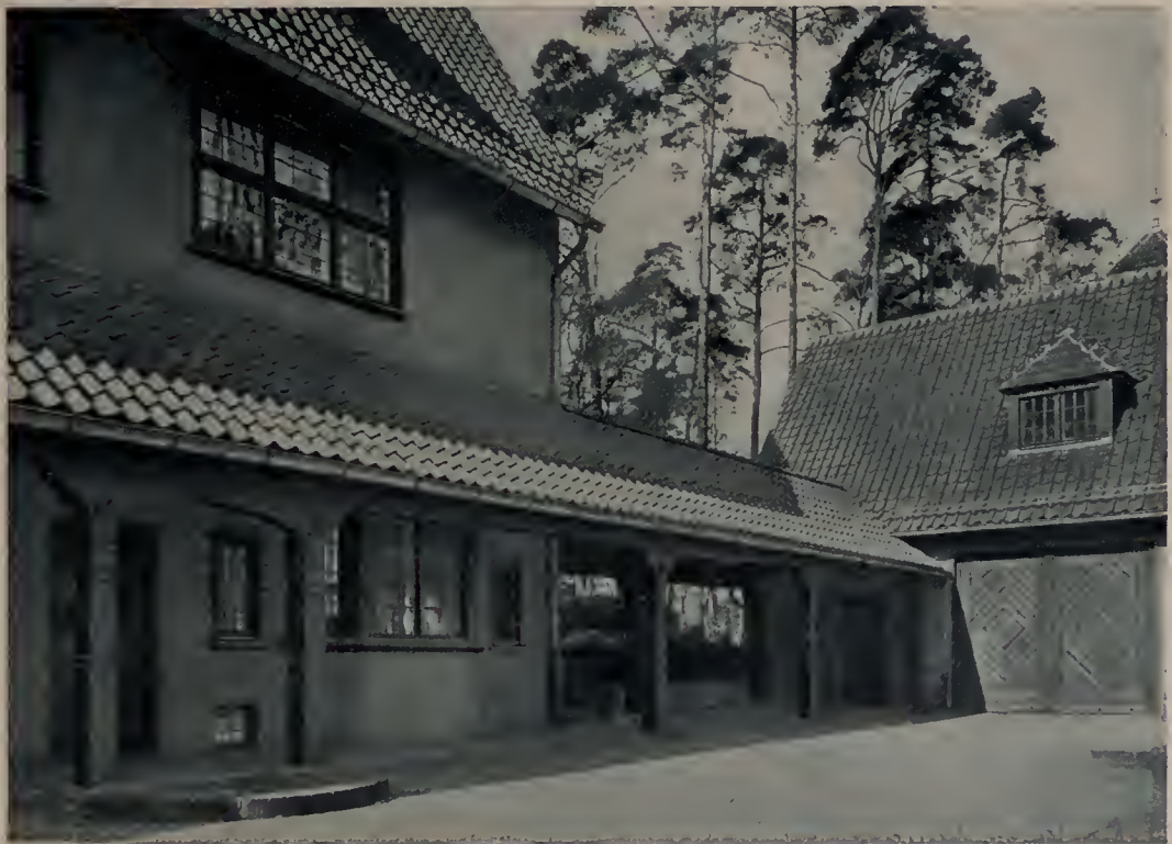
ARCH. H. STRAUMER @ LANDHAUS SCHOLTZ: BLICK V. WIRTSCHAFTSHOF DURCH D. ÜBERDECKTEN GANG NACH D. GARTEN (oben) @ WIRTSCHAFTSHOF M. ÜBERDECKTEM GANG Z. AUTOGARAGE (unten)
