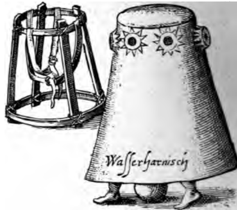
Abb. 742. Taucherglocke nach Keßler, 1616; links die Gurte des Tauchers.
