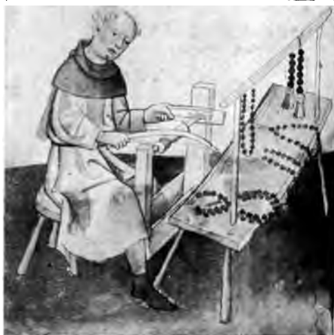
Abb. 148. Drehstuhl eines Rosenkranzmachers zu Nürnberg um 1435.
