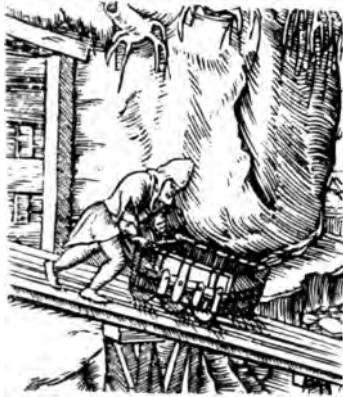
Abb. 246. Geleis aus Holz, nach Agricola, 1556.
