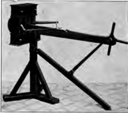
Abb. 250. Keilspanner, nach Philon rekonstruiert. Aus: Schramm, Bemerkungen zu der Rekonstruktion griechisch-römischer Geschütze, herausgegeben von der Gesellschaft für lothringische Geschichte und Altertumskunde in Metz, die auch die Klischees 250—252 u. 255 zur Verfügung stellte.
