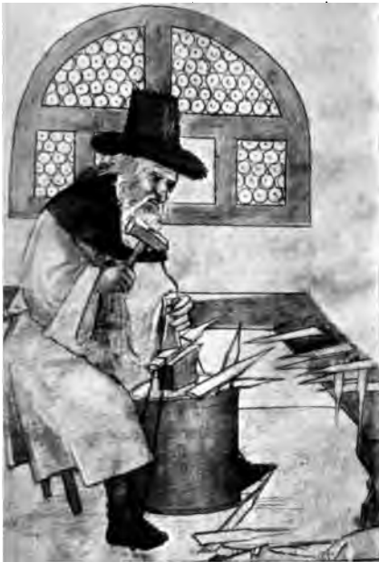
97. Feilenhauer, Nürnberg 1534; er hantiert mit Meißel und Hammer.
