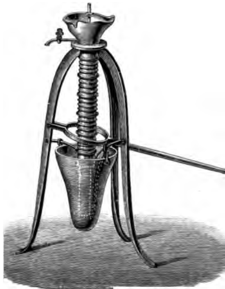
Abb. 454. Guericke's zweite Luftpumpe.
