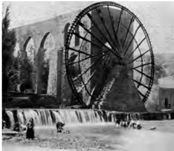
Abb. 546. Alte Radpumpe mit Wasserrad-Antrieb zu Hamâ in Syrien.
