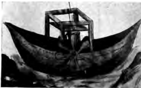
Abb. 606. Schaufelradschiff mit Antrieb durch Zahnräder und Spill, nach Kyeser 1405.
