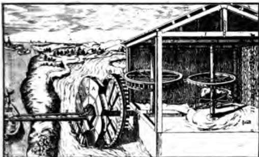
Abb. 547. Radpumpe mit Göpel-Antrieb, nach Zonca, 1607.
