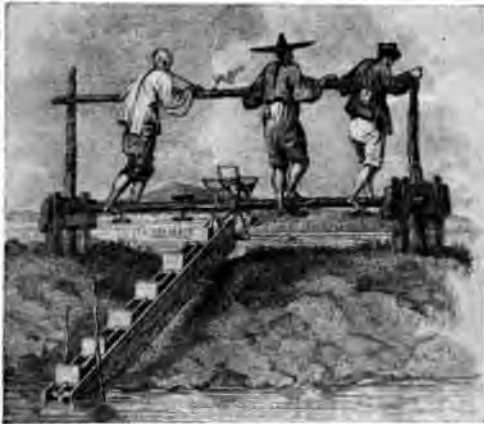
Abb. 543. Schaufelwerk in China, nach Staunton, 1797.
