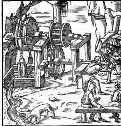
Abb. 544. Schöpfkolbenkette (Paternosterwerk), nach Agricola, 1556.
